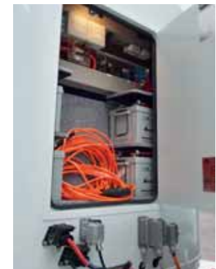
In der Stirnwand verbergen sich vier Back-up-Batterien und ein Wechselrichter.
