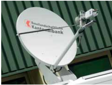
Die selbstjustierende Satellitenschüssel übernimmt die Datenkommunikation.
